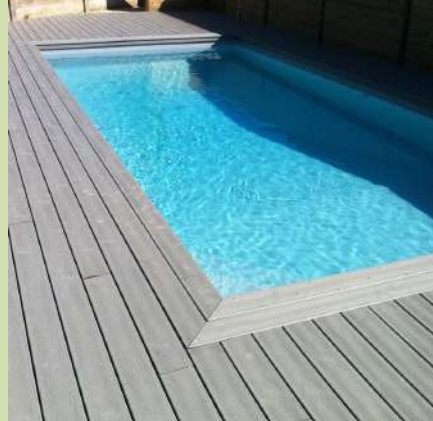
Bassin supérieur à 4,30 mètres de nage
